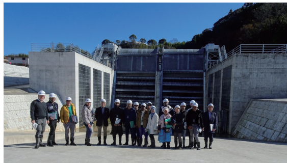
At the New Kusaka Floodway 新日下川放水路にて
