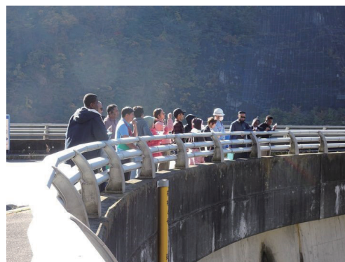
At the top of Kawaji Dam 川治ダムのダム頂にて
