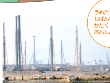
羽田空港の地盤改良工事の様子
