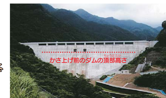
写真は壺瀬ダムの例
