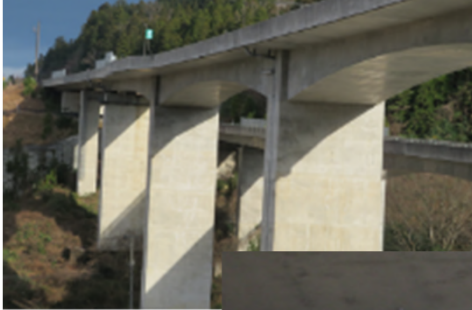
穴水道路 穴水高架橋(H14道示)
