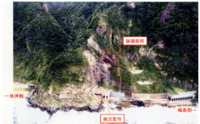
写真-7.3.25 被災箇所の被災前全景(国総研・土研資料より)
