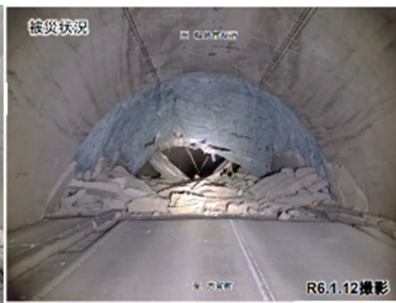
中屋トンネル(国道249号)
