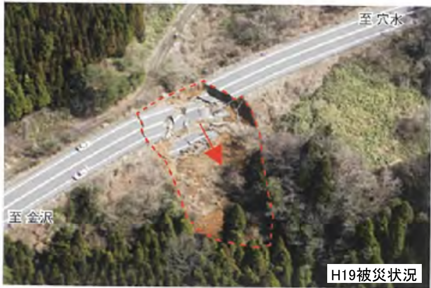
上下線の崩落 (H19.3月)
