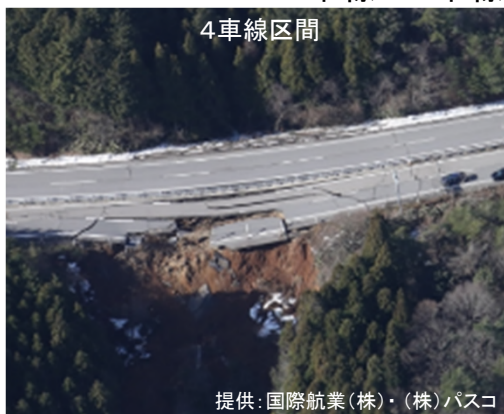
4車線／2車線区間の崩壊事例
