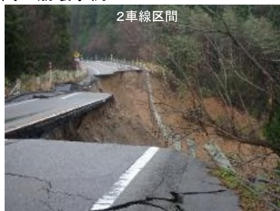
4車線／2車線区間の崩壊事例
