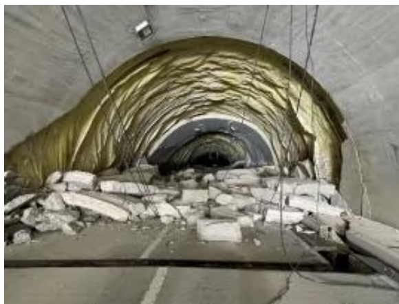
大谷トンネル(国道249号)
