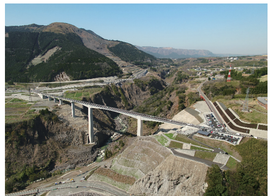
新阿蘇大橋開通（令和 3 年） （九州地方整備局 提供）
