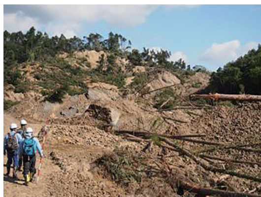
北海道胆振東部地震による地すべり災害 （平成 30 年）
