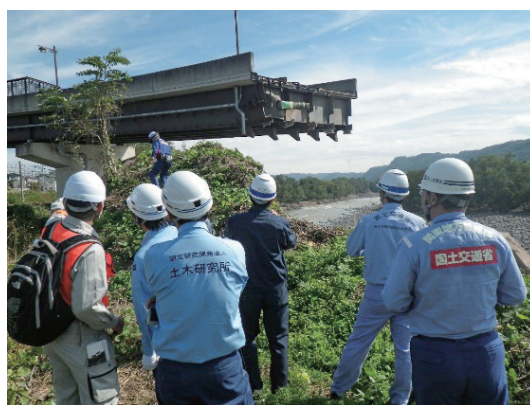
台風 19 号による市道海野宿橋の橋台の転倒及び 橋脚の側方地盤の流出被害（令和元年）
