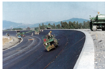
筑波研究学園都市に走行試走路 (着工) (S46)
