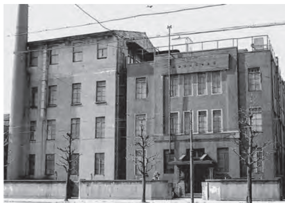
写真- 1.1.2 内務省土木試験所(駒込本所)
