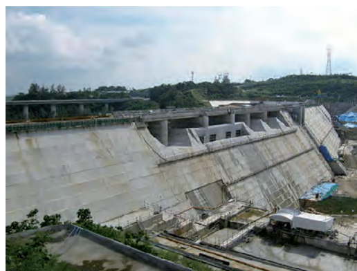
世界初の台形CSGダム(億首ダム)
