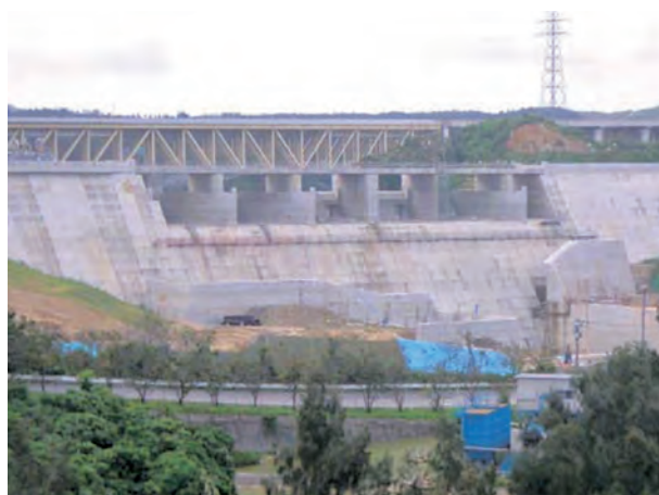
写真-2.2.1 完成間近な億首ダム
