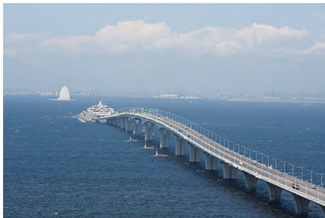
写真-3.1.2 東京湾横断道路 (写真提供：東日本高速道路（株）)
