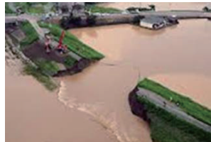
パイピングによる破堤
