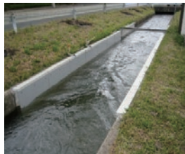
用水路補修の事例
