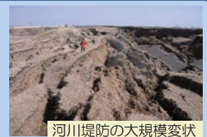
河川堤防の大規模変状と洪水への緊急対応
