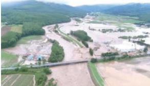
計画規模を超える洪水による破堤
