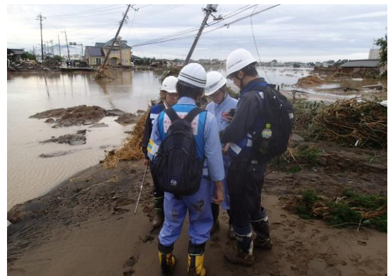
写真-2 堤防決壊の原因究明や復旧工法の検討 等のための技術支援
