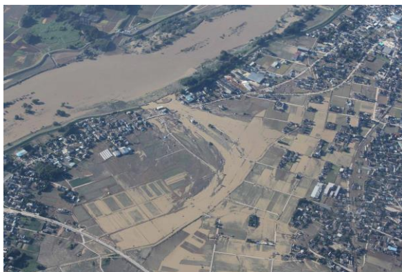
写真-1 鬼怒川で発生した堤防決壊 (提供:関東地方整備局)
