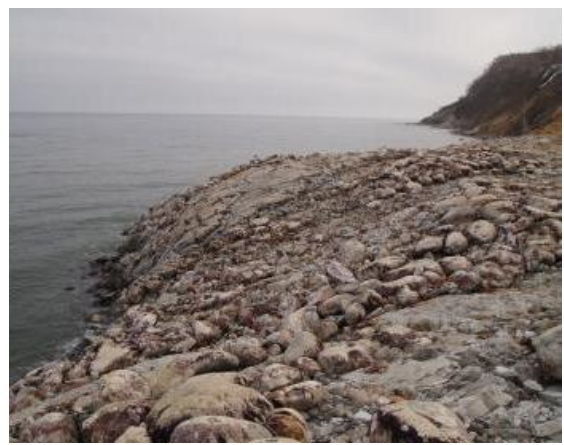
写真-2 地すべり末端の海岸隆起部
