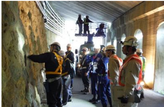
写真-1 沼尾シェッドの点検状況
