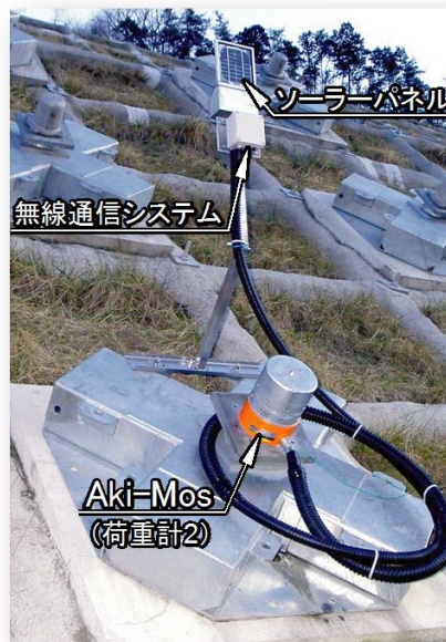
写真-1 システム設置状況
