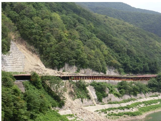
写真-1 現地状況全景
