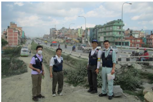
写真-1 国交省調査団によるカトマンズ市内の道路の沈下被害現場の調査
