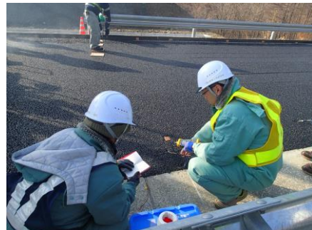
写真-2 北海道型 SMA の温度測定状況
