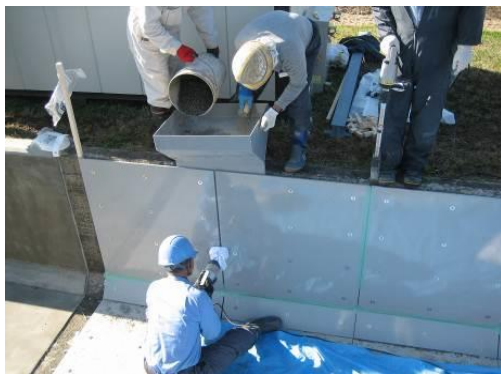
写真-1 側壁打設状況
