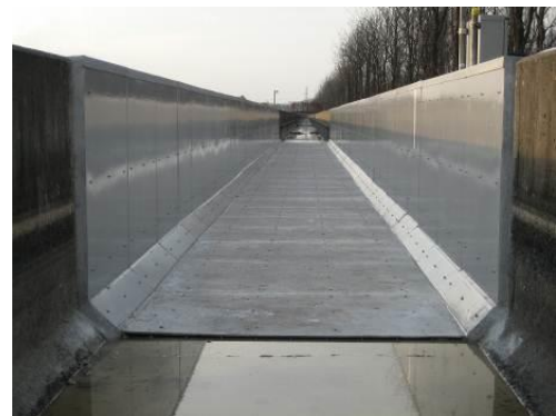
写真-2 完成状況
