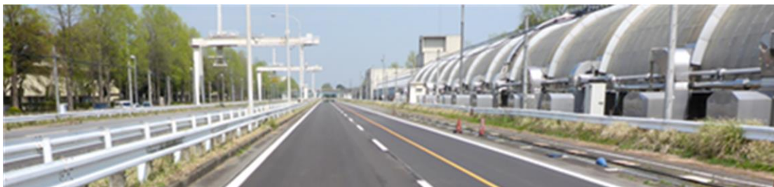
図-2 低燃費舗装の試験施工
