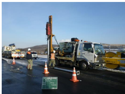
写真-2 端末基礎杭の打ち込み
