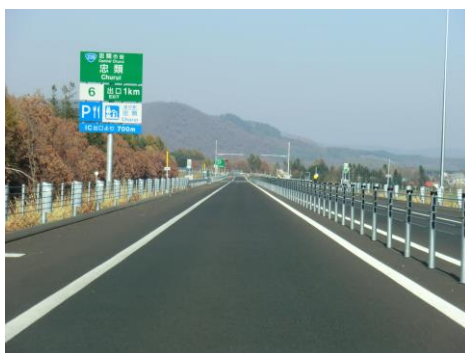
写真-1 帯広・広尾自動車道に導入されたワイヤロープ式防護柵
