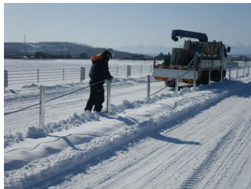
写真-3 ワイヤロープの敷設
