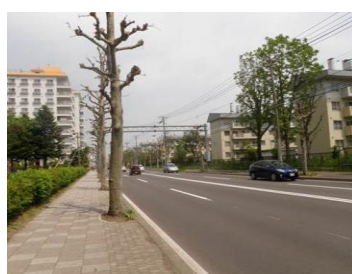
写真-2 枝葉を伸ばす空間があるにもかかわらず極端に切り詰められた街路樹
