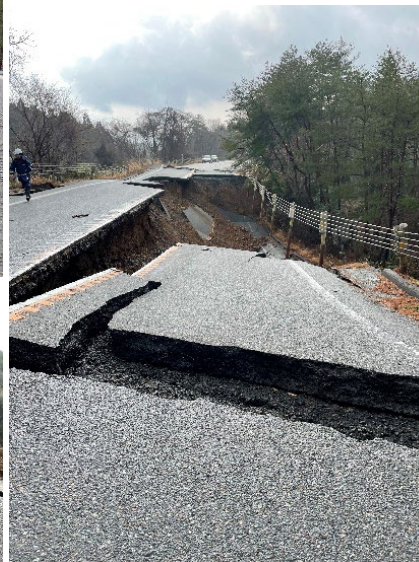
写真3 国道359号の盛土変状調査状況
