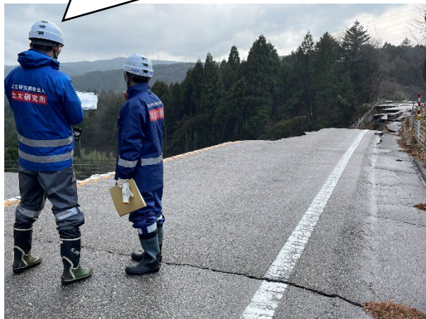
写真1 七尾市中島町谷内における盛土変状調査状況
