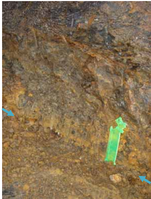
写真 - 3 崩壊面側部の断層面 (黄褐色粘土状。崩壊面となったと推定)
