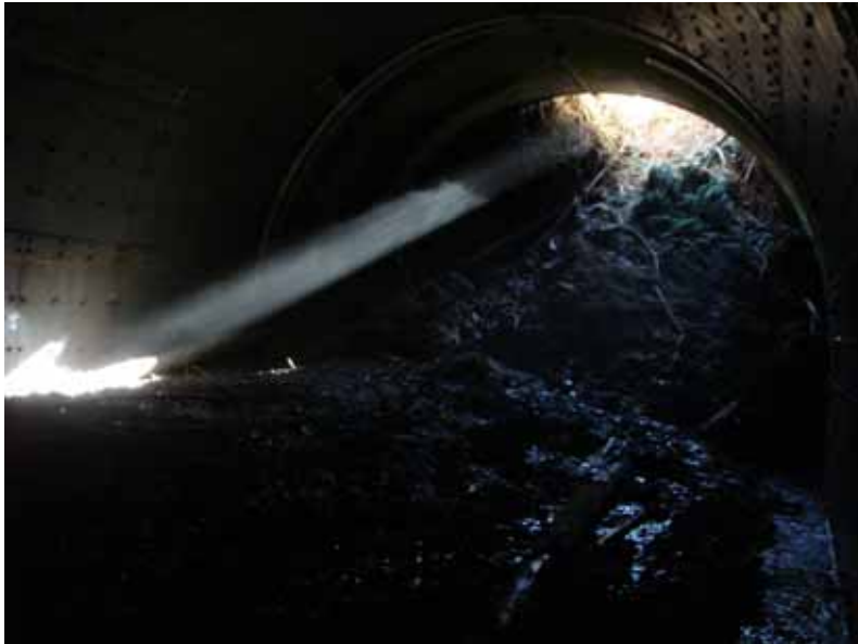
写真 -4 トンネル内の崩壊土砂の堆積状況。トンネルは破壊していないが坑口付近のほとんどを土砂が埋積している。
