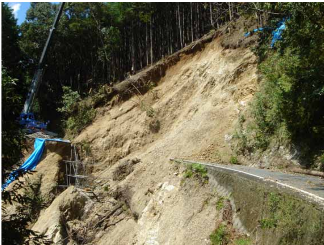
写真 - 2 国道169号新宮市熊野川町玉置口 崩壊地を北西方向に望む
