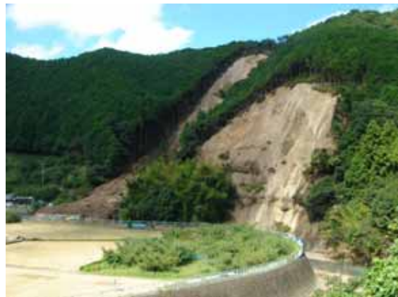
写真 -9 西側から (崩土が道路をオーバーフローしている)
