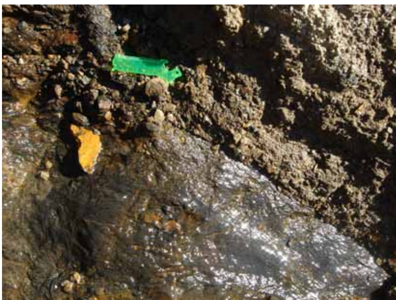
写真 -6 崩壊部中央付近の崩壊面（左下半部。右上は崩土）。 破碎質の泥質岩。
