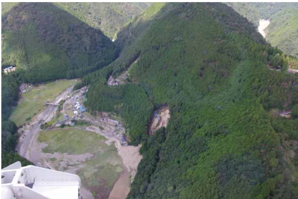
写真 1 国道169号新宮市熊野川町玉置口 崩落地写真（ヘリより空撮）
