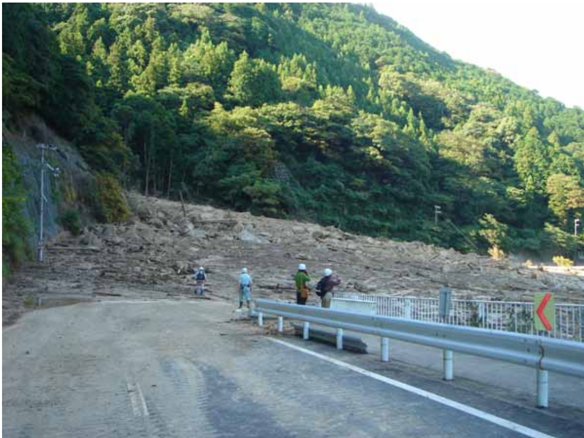
写真 -12 道路への土砂の堆積状況。
