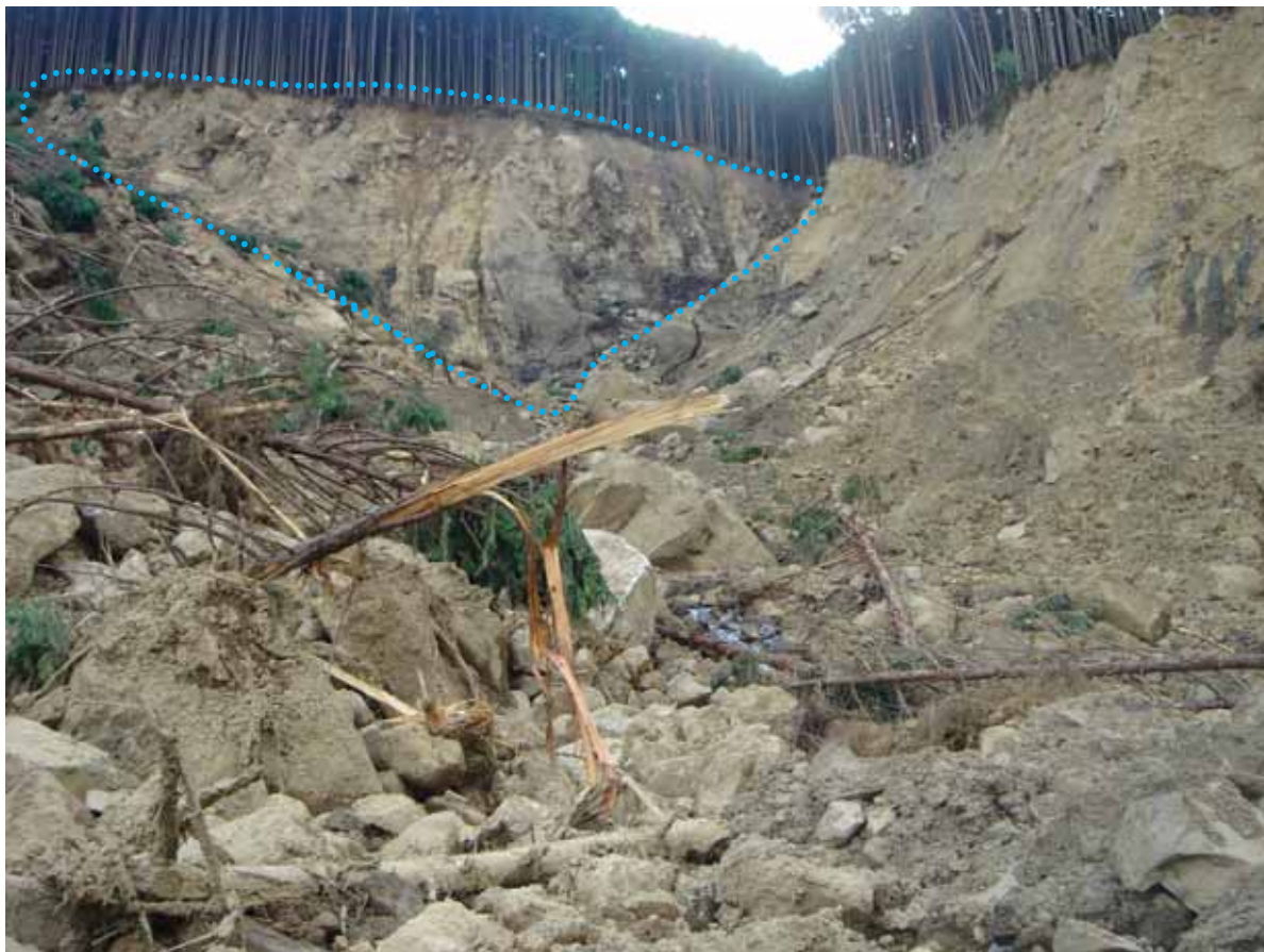
写真 -9 崩壊頭部滑落崖（青点線部）。基盤岩らしきものが見えるが、もともとかなり緩んでいる様子。
