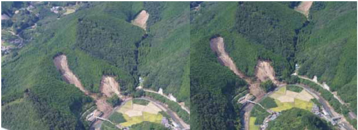
4 2 4号 法手見トンネル
