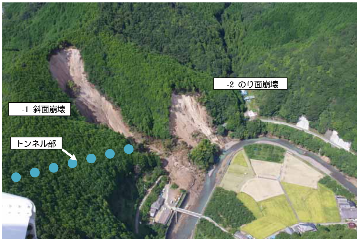
写真 -1 国道424号 みなべ町法手見トンネル 崩落地写真（ヘリより空撮） 向かって左がトンネル部。
