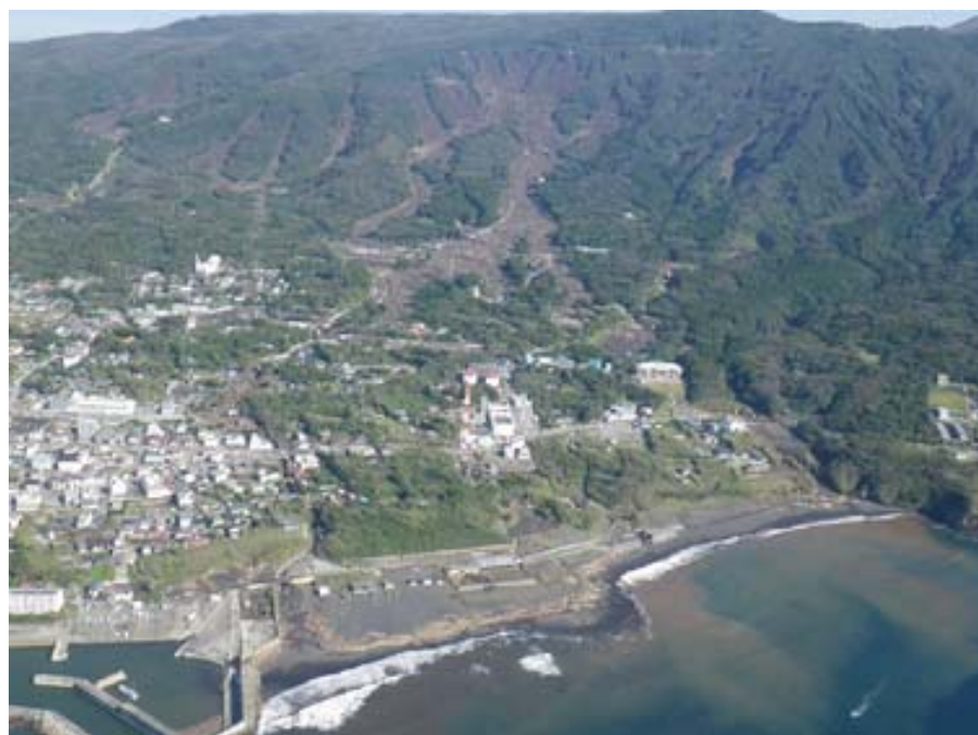
東京都伊豆大島で発生した土石流災害
