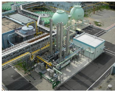
バイオ天然ガス化装置(神戸市東灘処理場)
