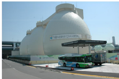
こうべバイオガスステーション(神戸市)
