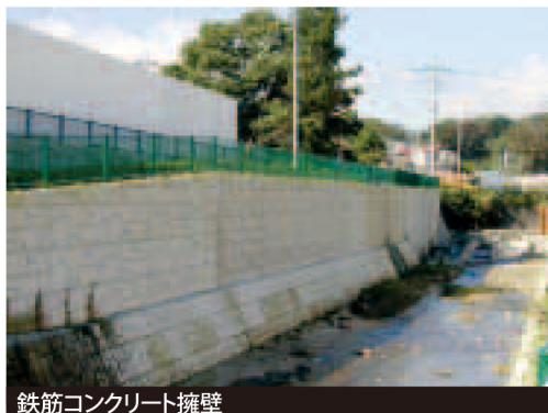
鉄筋コンクリート擁壁
