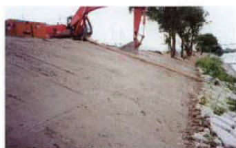
HGS 短繊維混合補強土被覆状況
