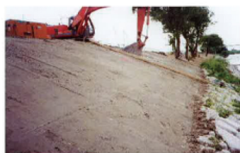
HGS 短繊維混合補強土被覆状況
