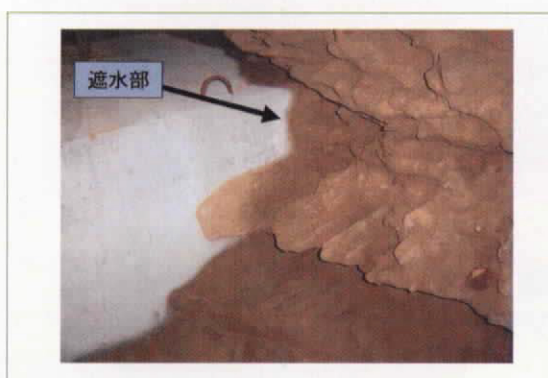
函体と遮水壁が密着している状況
