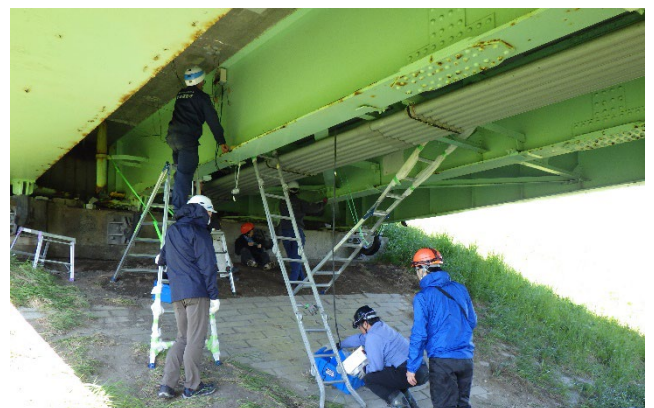
実橋梁の補修箇所の再劣化モニタリング
