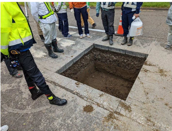
供用中の道路を開削し、劣化のメカニズムを検証
