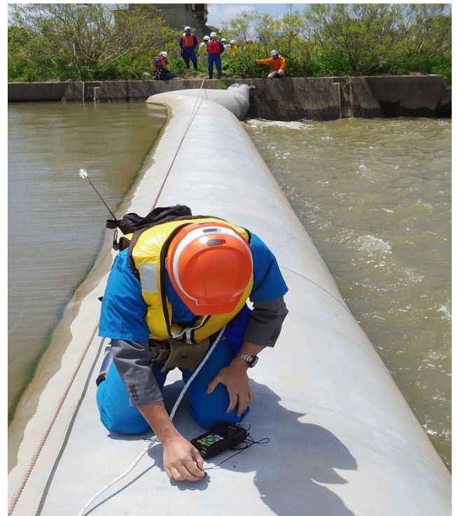
空気圧で倒伏できるゴム堰の補修調査
