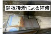
鋼板接着による補修
