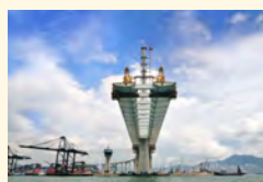
香港 ストーンカッターズ橋
