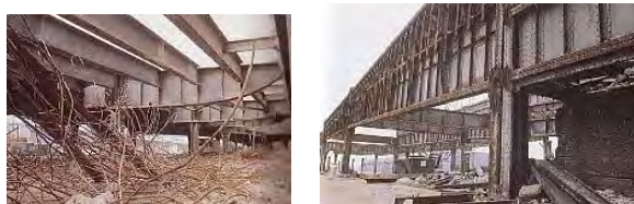
取り壊される老朽橋
