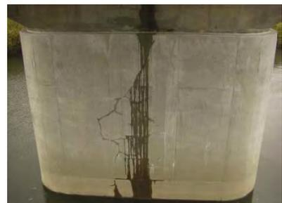
RC巻立て工法による耐震補強後に巻立て部のコンクリート表面にひび割れが生じた事例の調査
