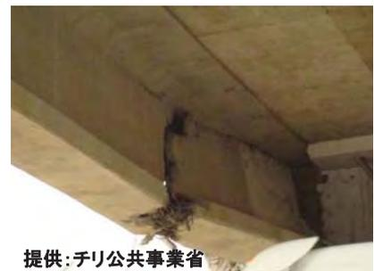
1990年代半ば以降に、民間委託として実施された道路事業で、建設コストの低減と建設期間の短縮を目的として技術提案された横桁や移動制限機構を設けないプレテンPC桁橋において被害が集中した。
