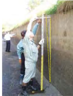
水路背面地盤の凍上による側壁の傾倒
