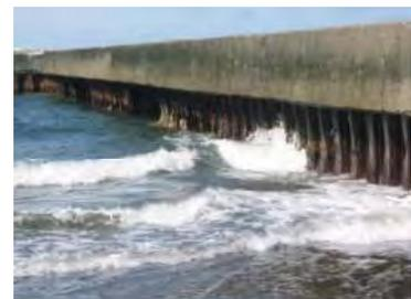
二重矢板式導流堤の海水作用と腐食による矢板の変形
