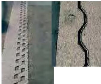
除雪作業に伴う伸縮装置の切削
