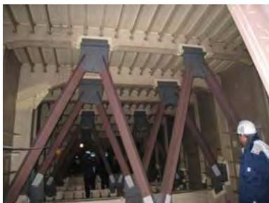
鋼製箱桁内に生じた疲労亀裂の対策として平成3年に実施されたトラス組によりダイヤフラムの補強がなされた橋のフォローアップ調査
