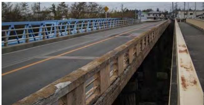
橋梁形式: 8径間RCT桁橋+2径間PC床版橋
