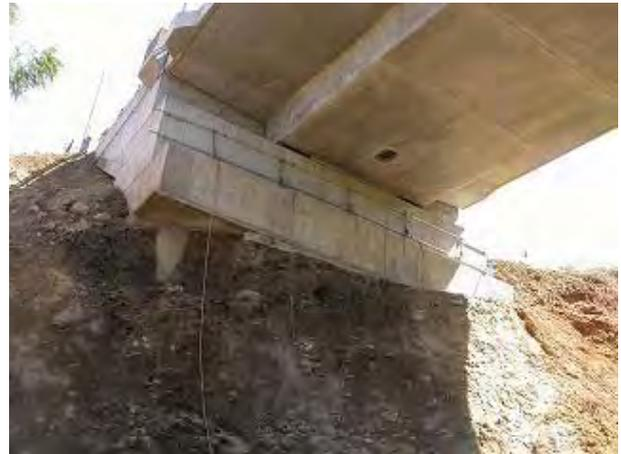
周辺地盤の崩落に伴う杭頭部の露出
