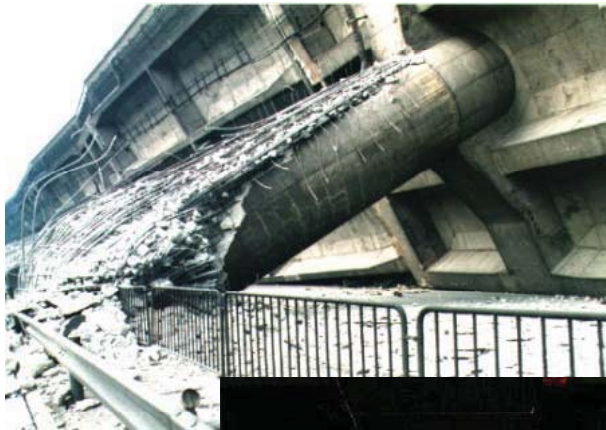
段落し部での損傷、破壊、倒壊
