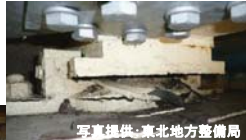
可動支承における 桁の振動跡
