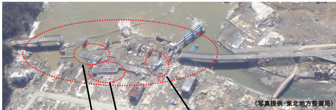
上部構造の一部径間が流出した橋
