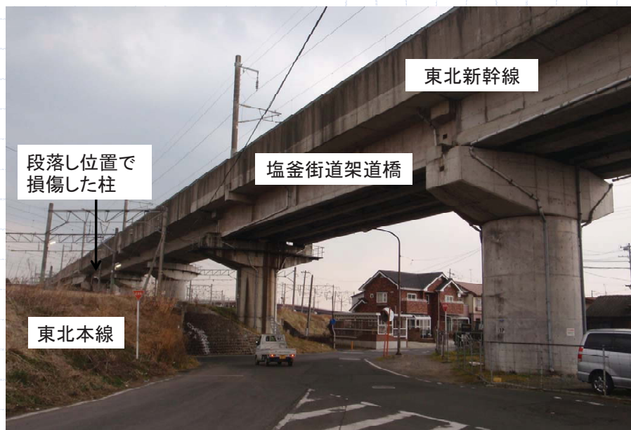
東北新幹線 岩切高架橋
