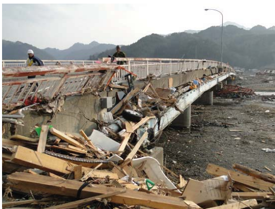
上部構造の高さにまで津波の遡上の痕跡があるが、流出していない橋
