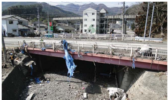
上部構造の高さにまで津波の遡上の痕跡があるが、流出していない橋
