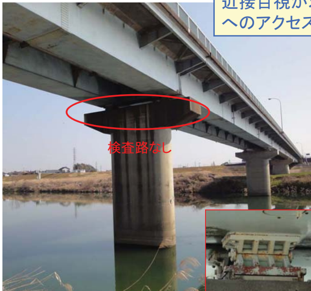
河川渡河橋の低水路部橋脚上の支承の点検
