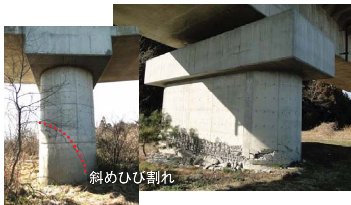
段落し部の損傷（地震後全面通行止め）
