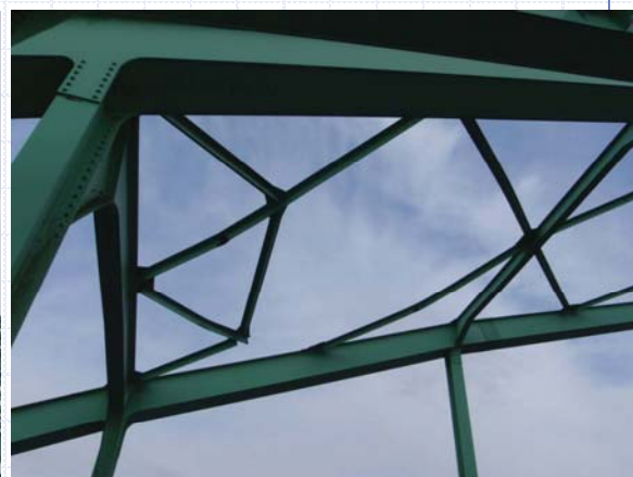
トラス上横斜材の破断
