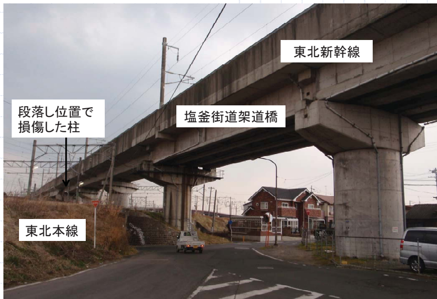
東北新幹線 岩切高架橋
