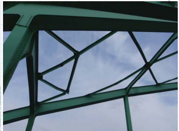
トラス上横斜材の破断
