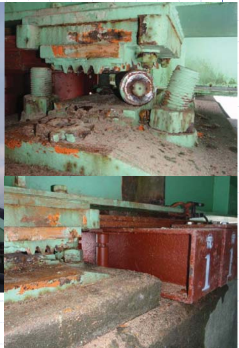
歩道橋部 ローラーの逸脱・サンドルによる仮支持
