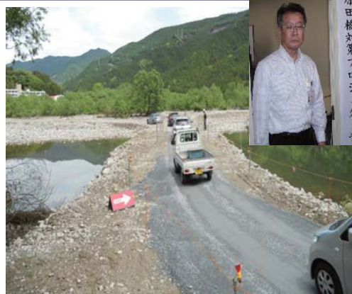
河川内緊急通路
