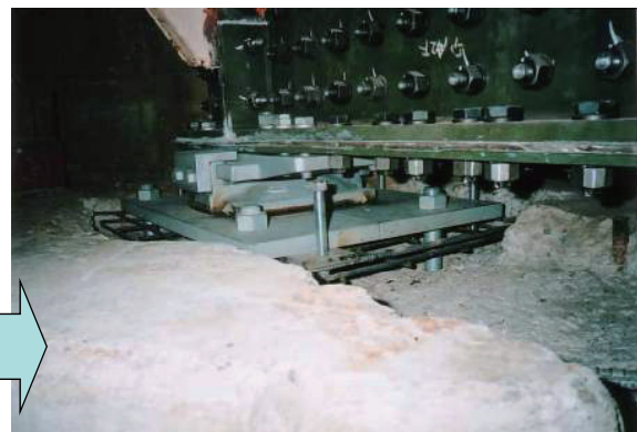
溶融亜鉛メッキ仕様の支承へ取替え
