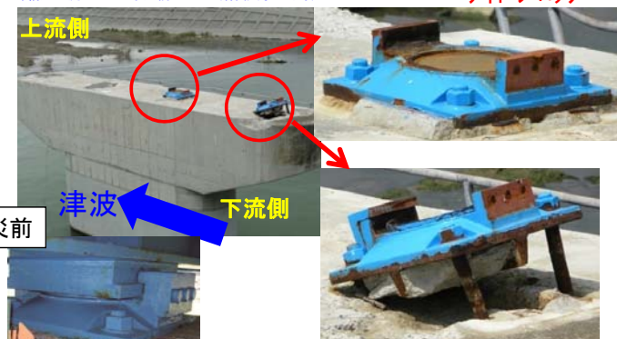
上部構造が流出した小泉大橋における鋼製支承の破壊モード
