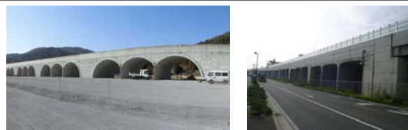
橋梁構造と土工構造の境界的な構造：連続カルバート
