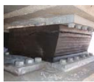
地震時水平力分散型ゴム支承の破断
