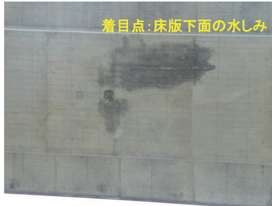
箱桁内部に配置された排水管に不具合を生じた事例
