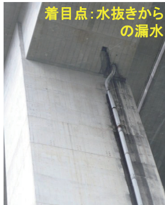
箱桁内部に配置された排水管に不具合を生じた事例
