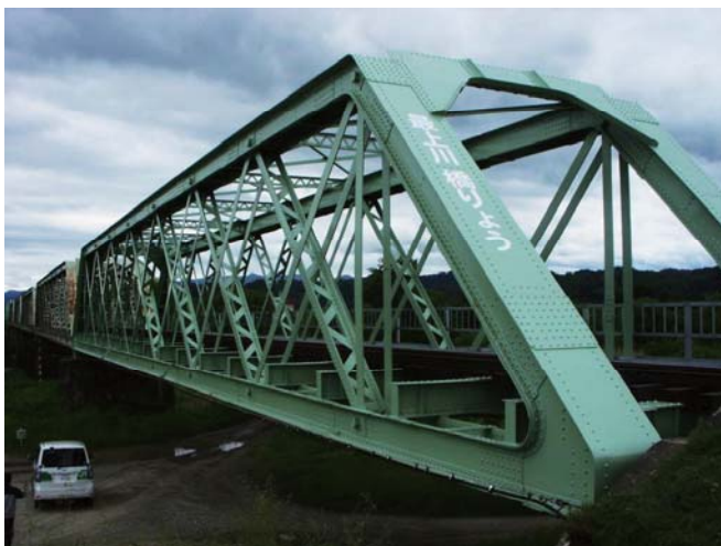
駅 間 左沢線 羽前長崎・南寒河江間 名 称 最上川橋りょう 形 式 ダブルワーレントラス 製作年 1886年[経年129年]
