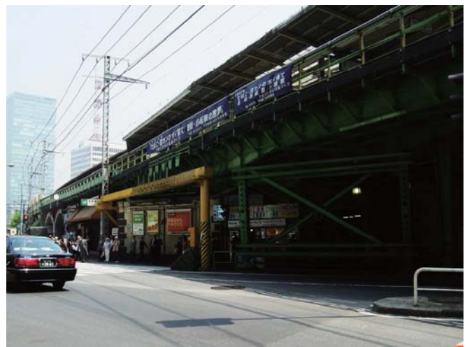
駅 間 東海道線 有楽町・新橋間 名 称 第2有楽橋架道橋 形 式 下路プレートガーダー 製作年 1908年[経年107年]
