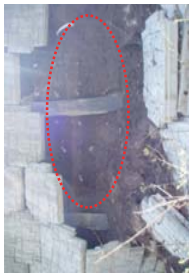
崩壊部の盛土の固化
