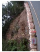
奄美大島豪雨による切土法面崩落 → 復旧に3日(H22.10 奄美市)
