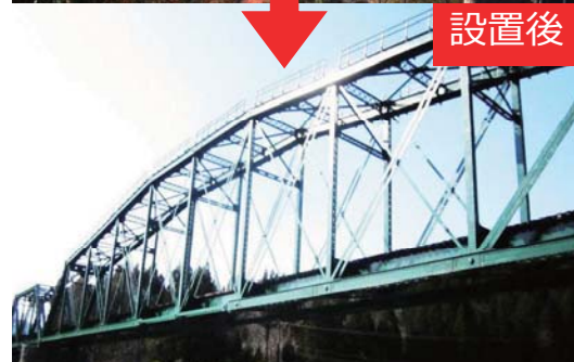
検査足場による方法
