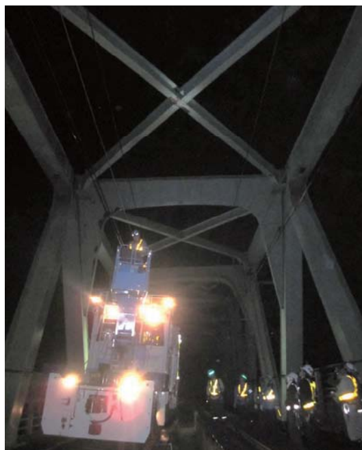
高所作業車による方法
