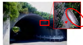
不同沈下による躯体の亀裂損傷(H23.11) → 現在、経過観察中 → 修復方法が確定できていない
