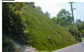
切土(法面保護)
