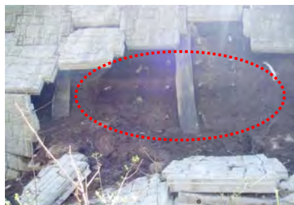
崩壊部の盛土の固化
