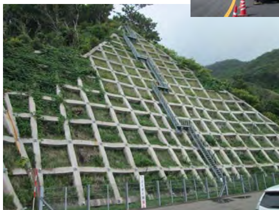
点検用通路を設置した事例
