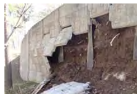
補強土壁の壁面パネル落下(H25.4) → 片側交互規制、大型車通行止め → 1年以上経過の現在も復旧できず
