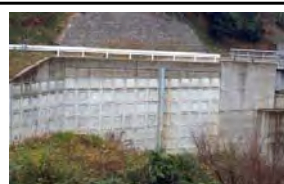
盛土(補強土壁)
