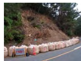
奄美大島豪雨による切土法面崩落 → 復旧に3日(H22.10 奄美市)
