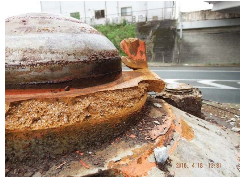
写真-3 ピボット支承(下沓拡大)
