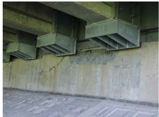
写真2 橋台の損傷
