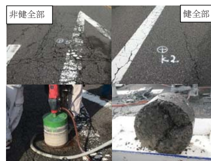
路面状態、コア採取の様子
