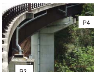
写真-3 桁の残留変位
