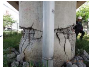
写真-5 市道(1-3)中央線・中央線陸橋
