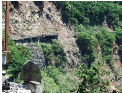
村道栃の木～立野線 戸下大橋
