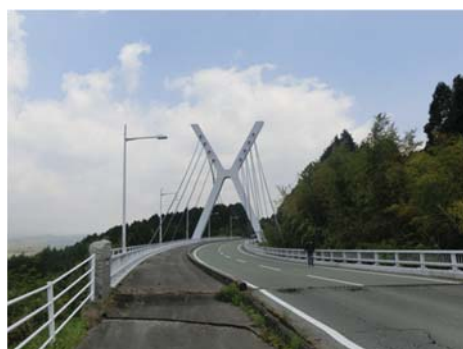
写真-1 桑鶴大橋の全景 (A1側から)
