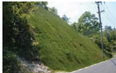
切土(法面保護)
