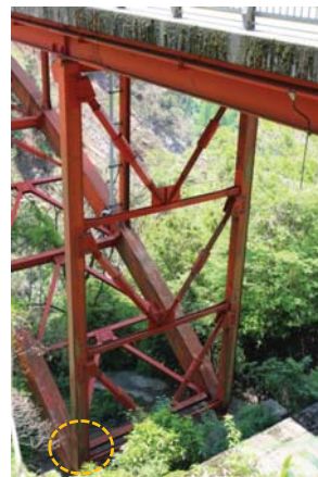
写真-2 座屈拘束ブレースが取り付けられた端柱基部のボルトの破損(南阿蘇橋)
