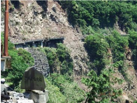
写真-3 斜面崩壊と橋梁の流出
