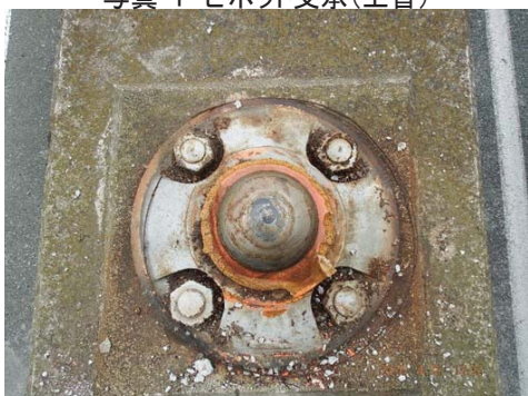
写真-2 ピボット支承(下沓)
