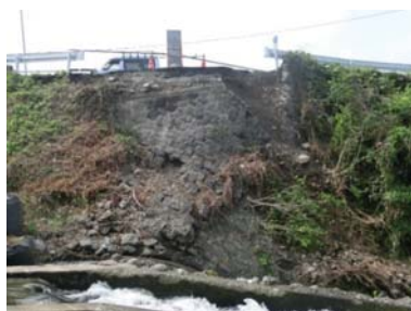
写真-1 左岸側橋台
