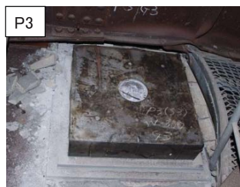
写真-1 ゴム支承の損傷状態
