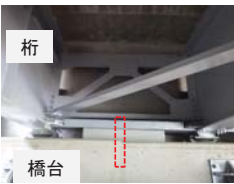
写真-3 アンカーバー のイメージ
