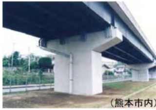
写真-1 国道3号 跨線部
