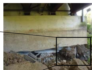
写真-3 A1橋台の基礎の露出
