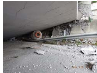
写真-4 ロッキング橋脚の 脱落・転倒
