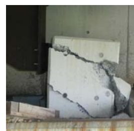
写真-4 A1橋台の横変 位拘束構造の損傷
