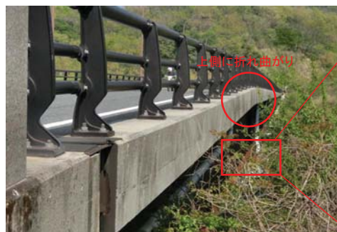
写真-3 A1-P1間での主桁の座屈
