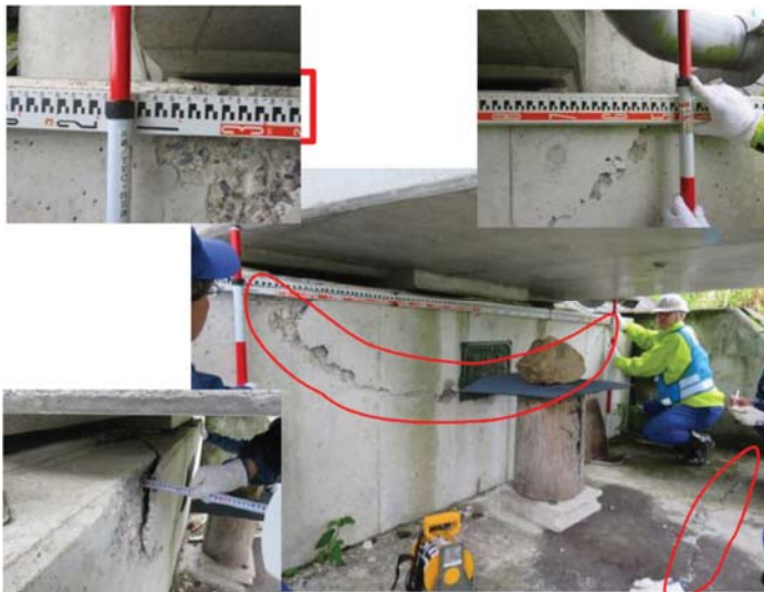
写真1 橋台の損傷
