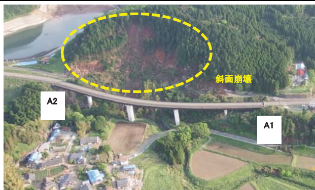
写真-1 大切畑大橋全景
