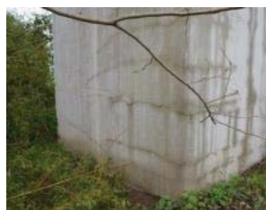
写真-5 P2橋脚のひび割れ
