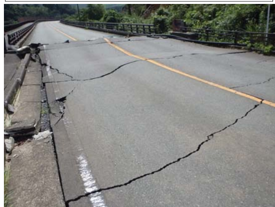
写真-2 大切畑大橋(A1側から)
