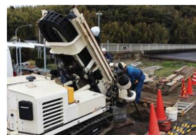
杭間地盤調査の状況
