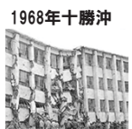
RC柱のせん断破壊
