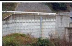
盛土(補強土壁)
