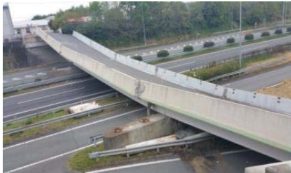
県道小川嘉島線 府領第一橋
