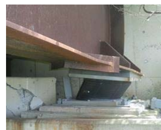
写真-3 A1橋台ゴム支承上 の下フランジの変形
