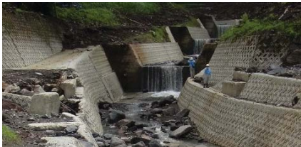
村道獄大道・吉岡線 宇曾谷橋
