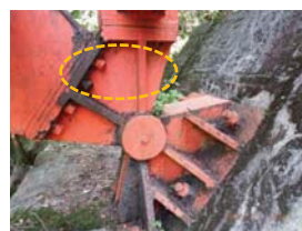
写真-2 座屈拘束ブレースが取り付けられた端柱基部のボルトの破損(南阿蘇橋)
