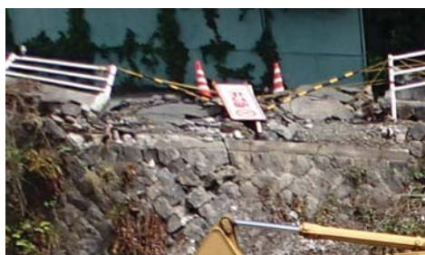
写真-2 右岸側橋台上部
