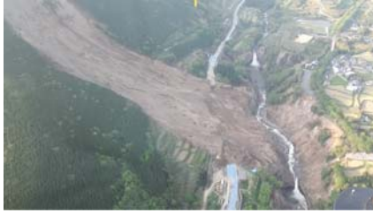
国道325号 阿蘇大橋
