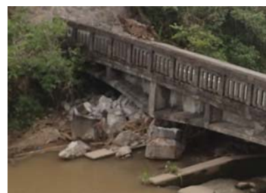
写真-3 左岸側橋脚
