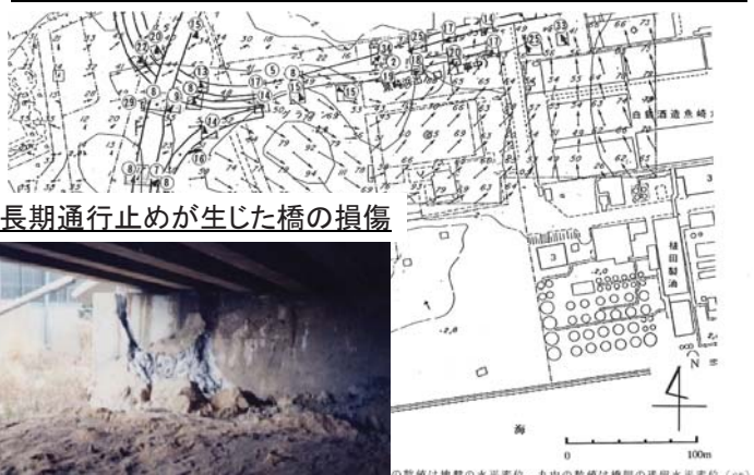
埋立て地区における橋の側方移動の被害(兵庫県南部地震)
