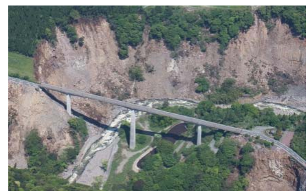
村道柵の木～立野線 阿蘇長陽大橋
