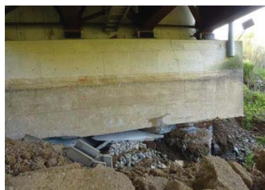
写真-2 橋台周辺での地盤 変状による橋台の沈下 (県道熊本高森線・俵山大橋)
