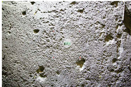
コンクリート表面（海水による侵食跡）
