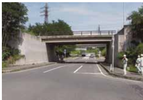
写真-1 第二丸山跨道橋（現在）
