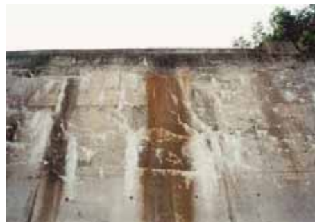
写真-2 平成10年補修前の状況
