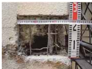
写真-4 はつり調査による鉄筋の状態の確認
