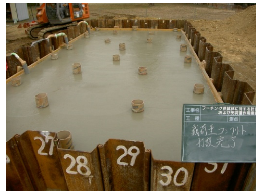
(上載コンクリート打設状況)
