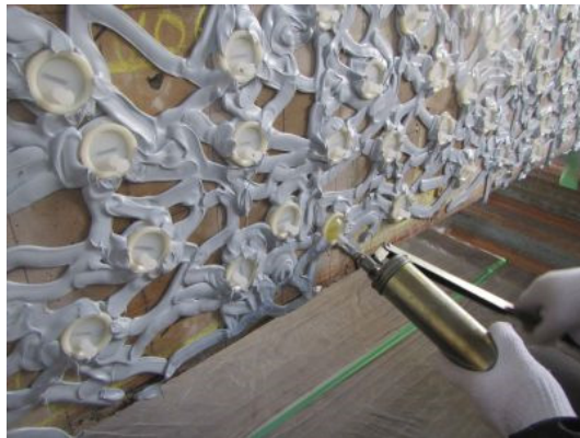
(注入材の注入状況)
