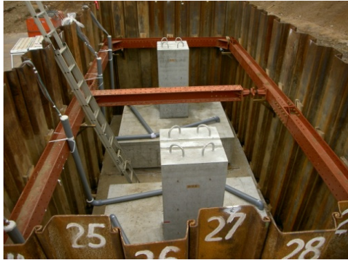
(供試体設置状況)
