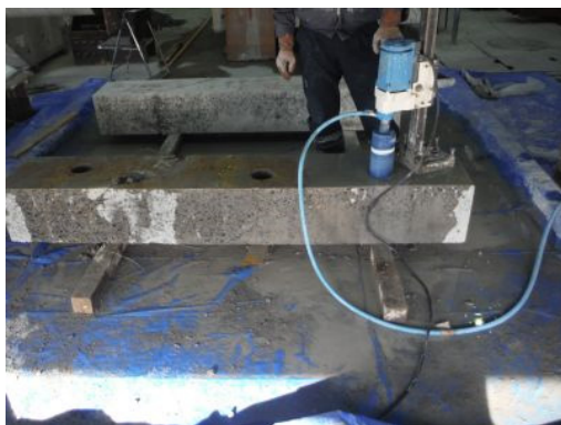
(コアドリルによる削孔状況)
