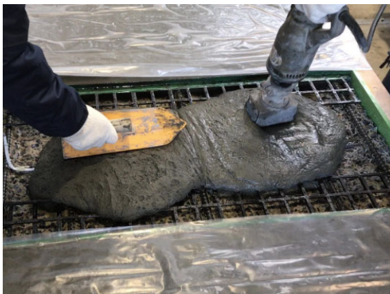
図-1.2.3.6 補修材打込み状況
