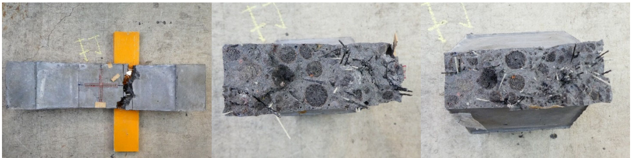
(b)床版-1 の側面と破断面
