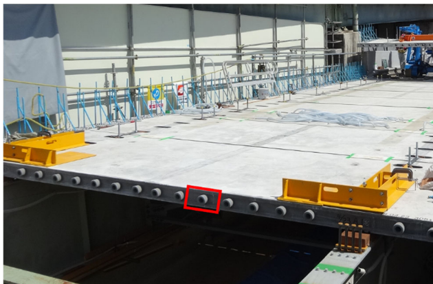
図-2.2.2.6 接合部のスポンジリング
