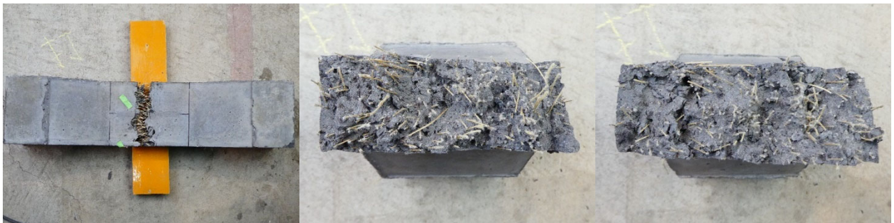
(c)床版 (間) -5 の側面と破断面
