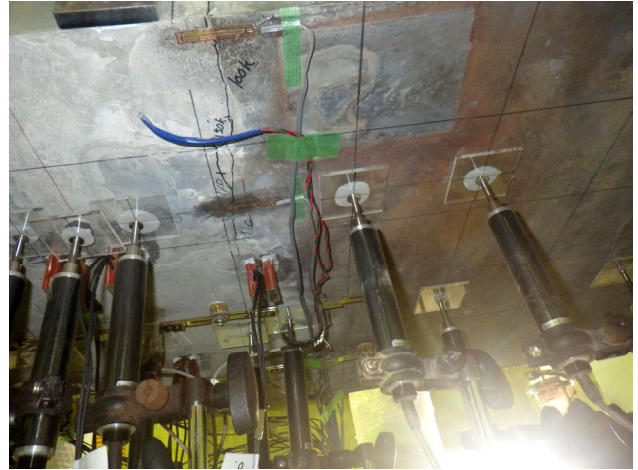
(b) 供試体 JS1, プレキャスト側突起部のひび割れ
