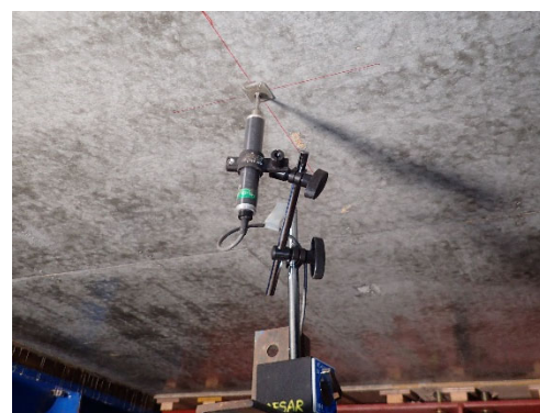
図-2.2.4.3 下面の変位計の設置状況
