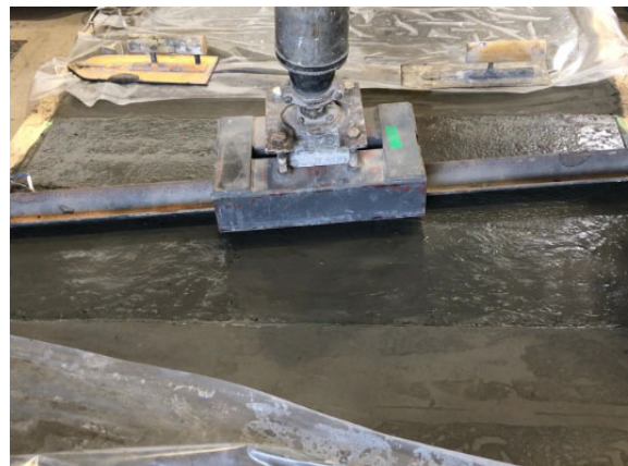
図-1.2.3.7 補修材上面仕上げ状況
