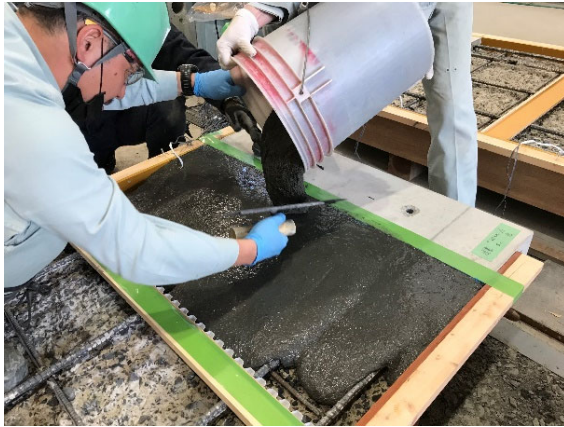
図-1.2.5.4 補修材の施工状況 (KJ)
