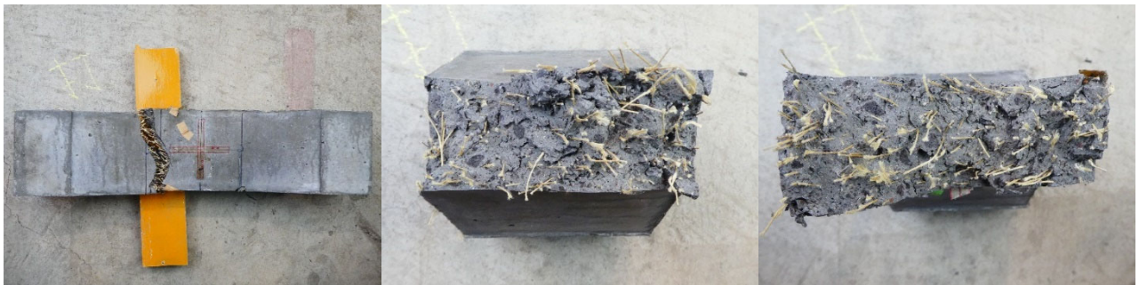
(b)床版 (間) -1 の側面と破断面
