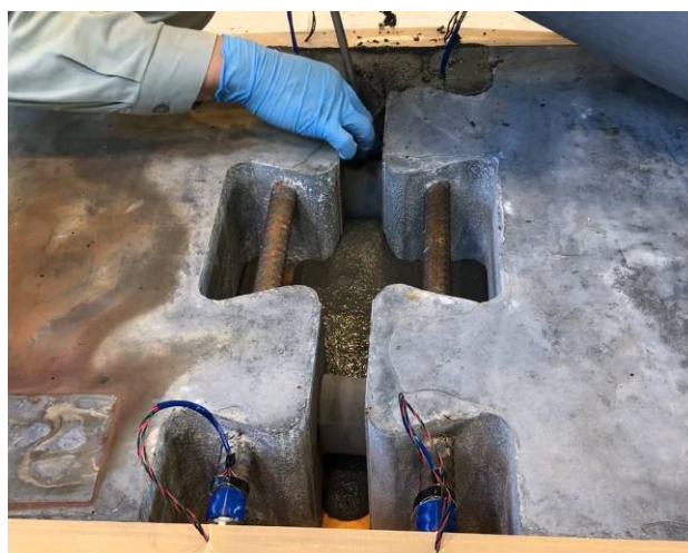
図-2.8.2.4 間詰め材 UHPFRC の打設
