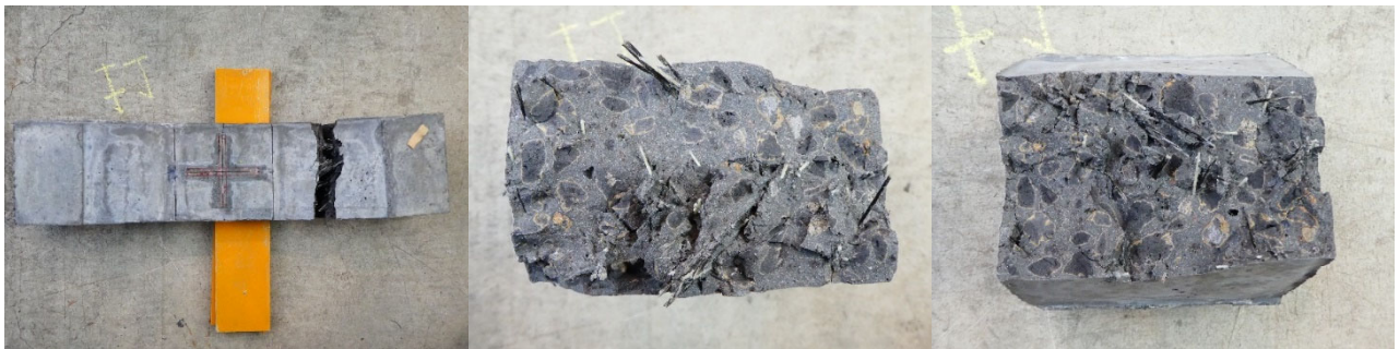
(d)床版-6 の側面と破断面
