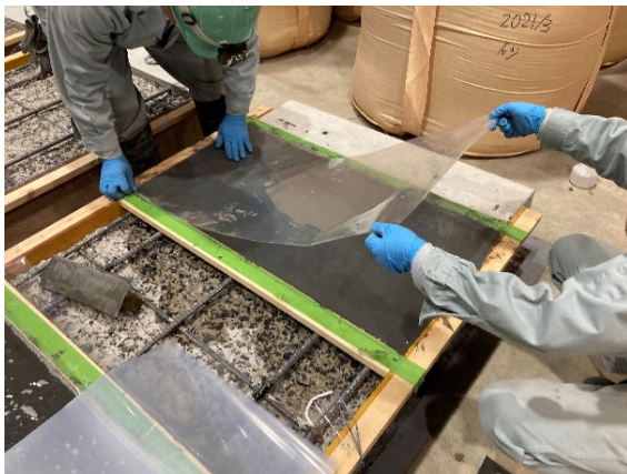
図-1.2.5.5 補修材の養生状況 (KJ)
