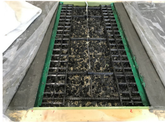
図-1.2.3.5 中央部打設前状況（散水処理）
