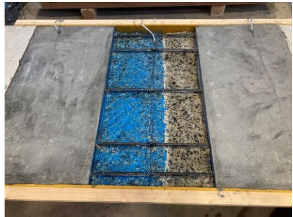
図-1.2.4.5 下地コンクリート処理（中央部）
