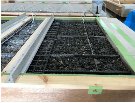
図-1.2.3.2 型枠の設置状況
