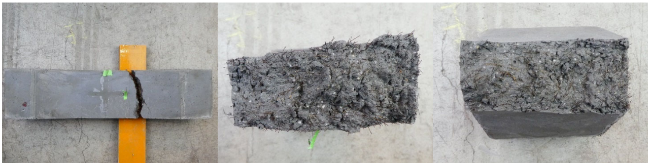
(c)床版(間) -5 の側面と破断面
