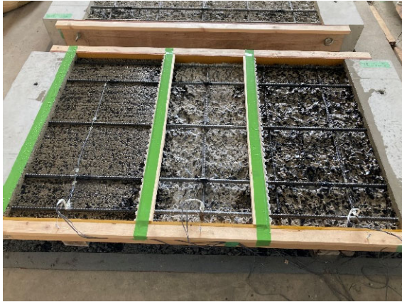
図-1.2.5.2 型枠の設置状況 (KJ)
