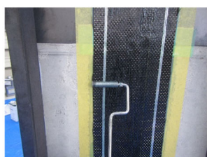
5) CFRPシート貼付
