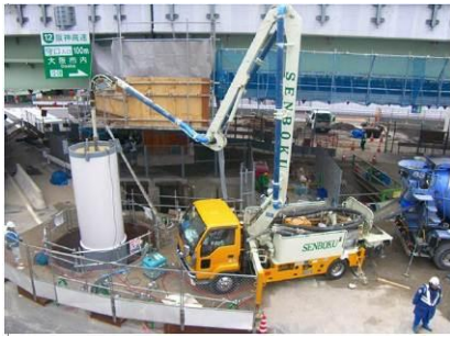
Photo-5 Pouring concrete
