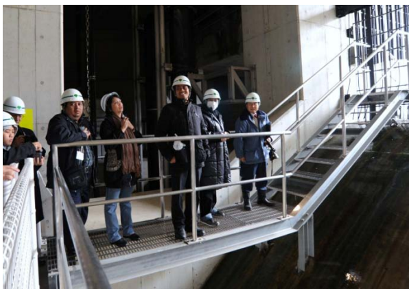
東京都 白子川調節池内の視察
