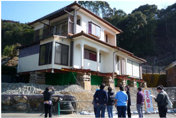
家屋嵩上げ最中の現場の説明
