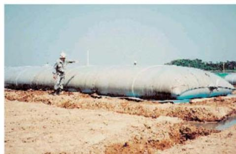
高含水のダイオキシン類汚染土壌を脱水・減量化するとともに封じ込めることが可能な「袋詰脱水処理工法」
