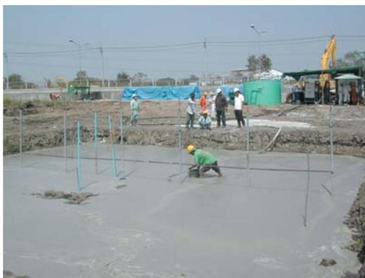
気泡混合土の打設
