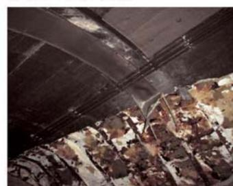
写真-2 一般国道17号和南津トンネル（覆工コンクリートが剥落した箇所では、鋼製支保工が露出している）
