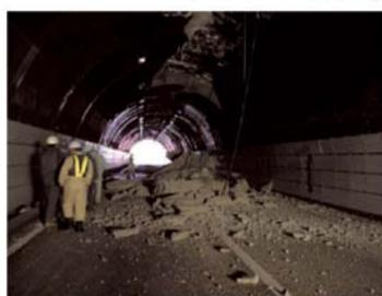
写真-1 一般国道17号和南津トンネル（長岡側坑口より約85mの地点で覆工コンクリートが落下）
