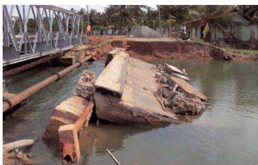
写真-2.3.2.13 津波により橋台裏が洗掘されて落下した橋と仮設橋 (スマトラ島沖地震・インド沖地震)
