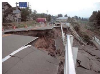
写真-3 一般国道17号川口町天納(263.46KP)での道路崩壊（沢浴いで、幅約40mにわたってすべり破壊）
