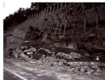
写真-4 一般国道17号川口町牛ヶ島(262.5KP)でのブロック積擁壁の崩壊（山側のブロック積擁壁が約20mにわたって崩壊）
