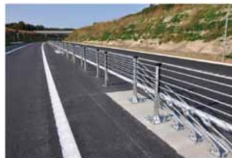
写真 16.3 高速道路の中央分離帯へ導入されたワイヤーロープ柵
