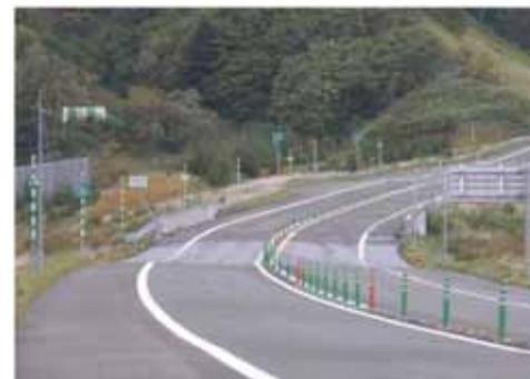
図 14.3 泥炭地盤上の道路の不同沈下
