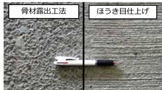
骨材露出工法とほうき目仕上げ
