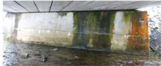
写真-1 試験施工橋梁の漏水状況 (右岸橋台前面)
