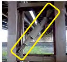
鋼材降伏系ダンパーの設置例
