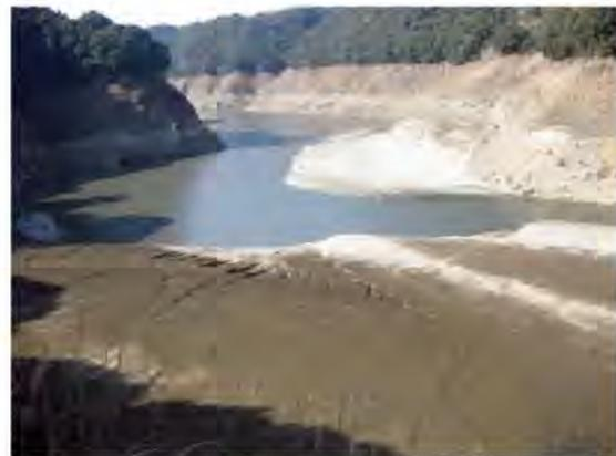
図-9.6 水位低下に伴う濁水発生状況
