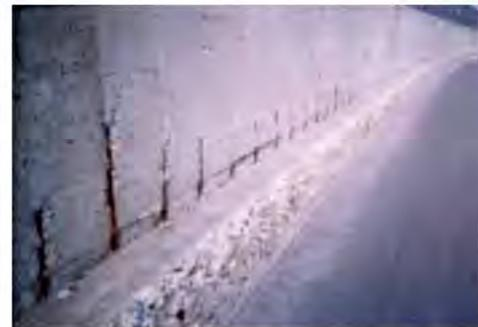
図-14.2 凍害・塩害によるRC壁高欄の複合劣化
