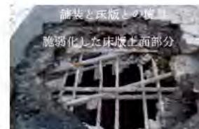
RC 床版の上面脆弱化後の陥没例
