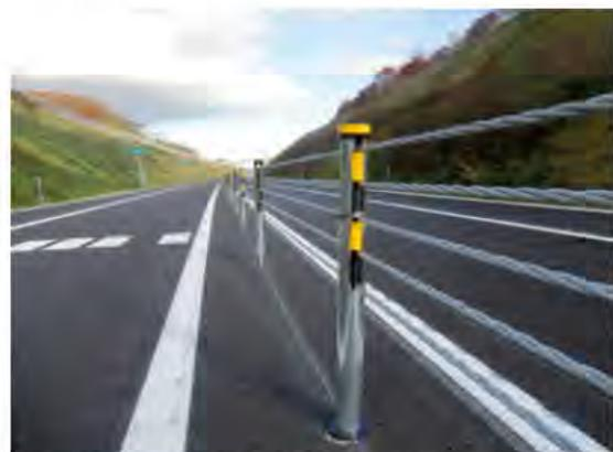
図-16.4 車線逸脱防止対策技術の導入例
