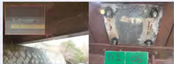
写真-1 橋梁の実態調査（左：外的要因による損傷、右：高欄取付部下面のベースプレートの腐食）
