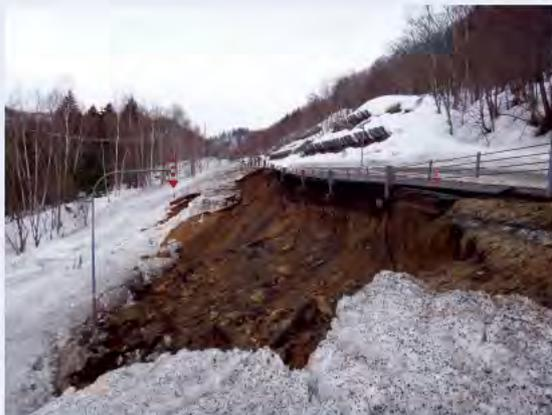
写真-1 国道 230 号の盛土法面の崩壊
