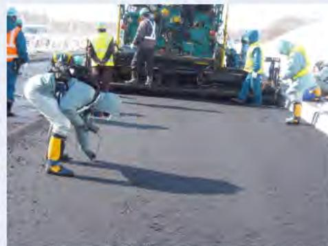
写真-2 中温化混合物の温度測定状況
