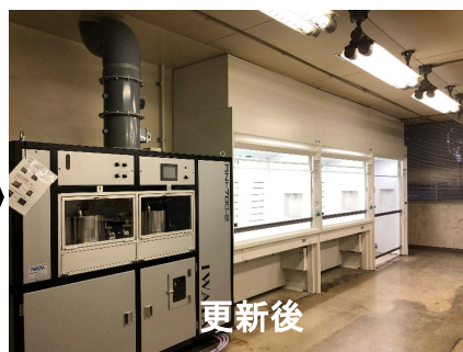
材料構造共同実験棟ドラフトチャンバー（局所排気設備）更新（つくば）[R2]
