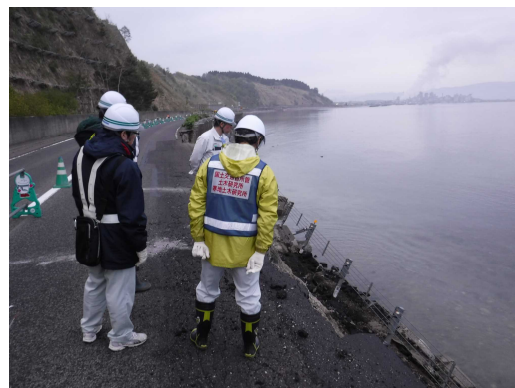
写真 - 1.2.3.4 現地調査の様子
