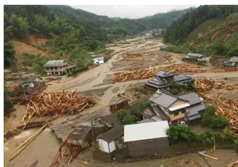
図-2 平成 29 年 7 月九州北部豪雨による流木流出（筑後川水系赤谷川）
