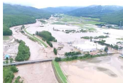
図-1 石狩川水系空知川の破堤状況（平成28年8月）
