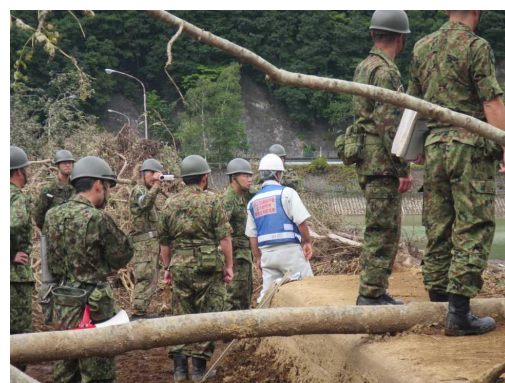
写真 - 1.1.3.16 厚真ダム復旧に向けた技術指導
