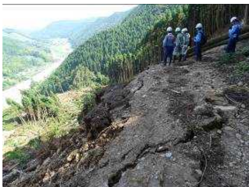
写真 - 1.1.3.7 地すべり崩壊の全景
