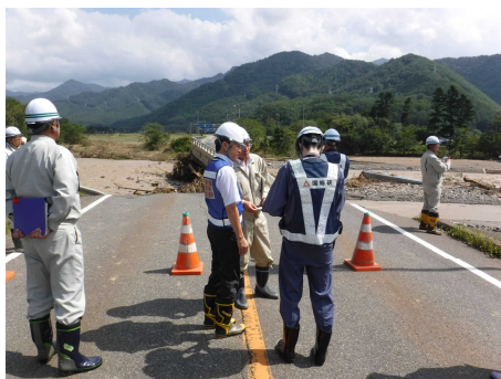
写真-1.1.3.5 R274 千呂露橋の現地調査状況
