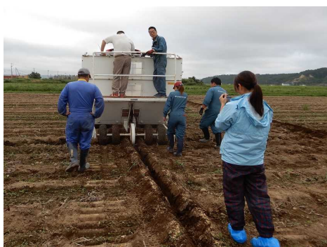
写真-1 有材心土破碎の施工状況
