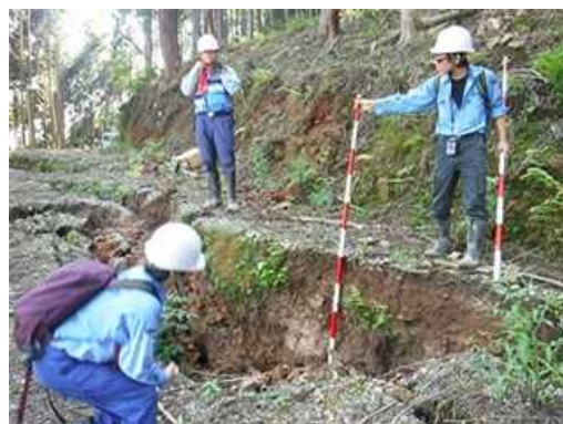
写真 - 1.1.3.8 地すべり箇所の調査の様子
