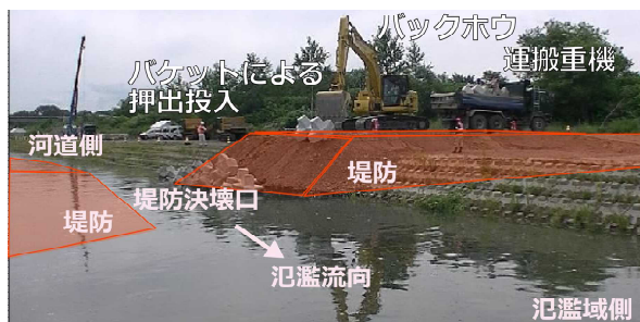
図-1 千代田実験水路を活用した重機による効率的な資材投入実験
