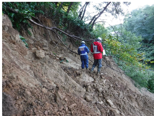
写真 - 1.1.3.10 表層崩壊箇所の調査の様子
