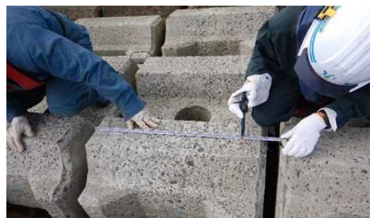
写真-1 航路護岸被覆ブロックコンクリートでのスケーリング深さの測定状況
