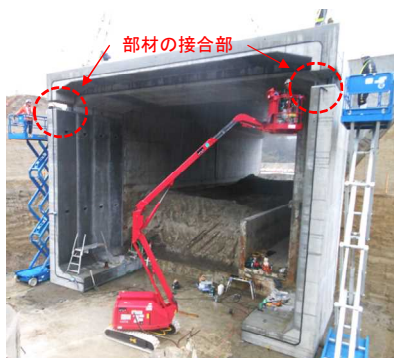
写真-1 プレキャスト部材同士の接合の例
