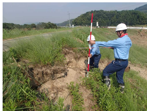
写真 - 1. 1. 3. 12 堤防の調査の様子
