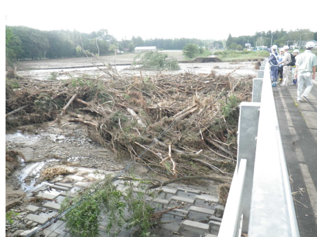
写真-1.1.3.6 R38 小林橋の現地調査状況
