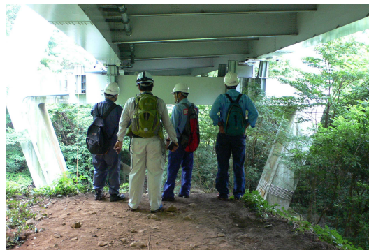
写真-1.1.3.2 被災橋梁の損傷状況調査
